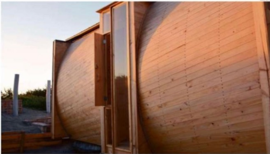
EDIFICIO QUE ALBERGA LA BIBLIOTECA EL PÓRTICO DE LOS HUÉSPEDES BUSCA QUE LA CONSTRUCCIÓN Y LOS MATERIALES SEAN PARTE DE LA GEOGRAFÍA.
